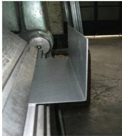
Güç kaynağı kutusunun caka yardımı ile bükülmesi
